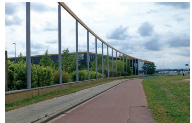
groene zone tussen gebouw en trottoir langs de Marconisingel
